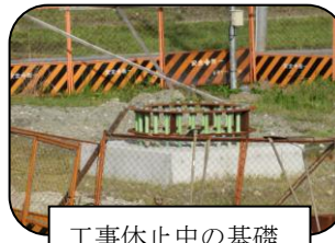
工事休止中の基礎
